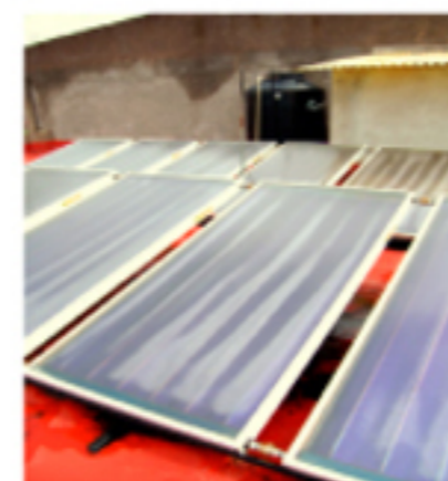
Colectores solares planos colocados
